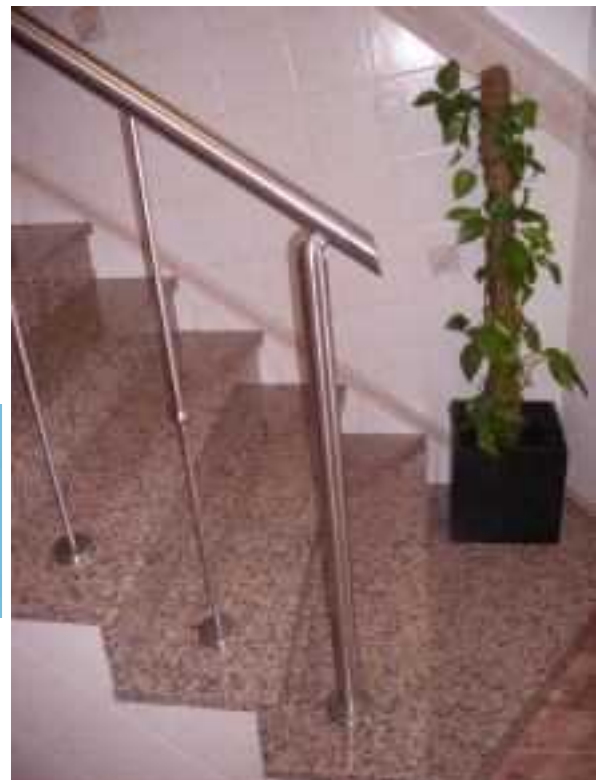
Curva final 42,4 em 316 acabamento esférico
